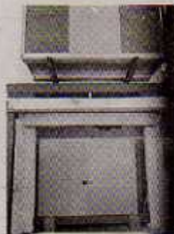
La planta de frío para las bóvedas
